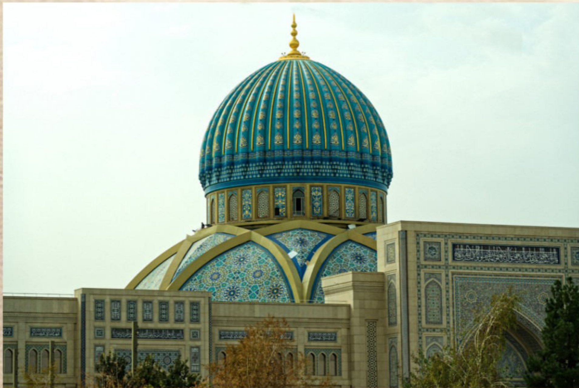
Mosquée du centre de civilisation islamique : un dôme construit sur une coupole réticulée.
