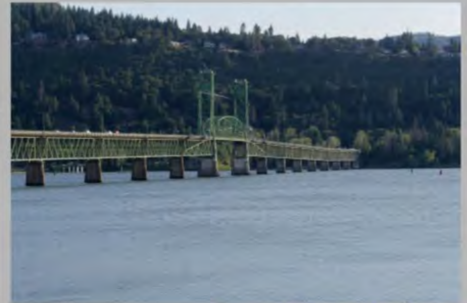
Columbia River à Hood River
