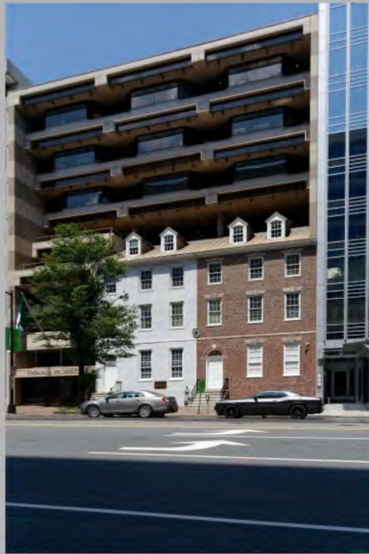
Bâtiment neuf enserrant un bâtiment ancien
