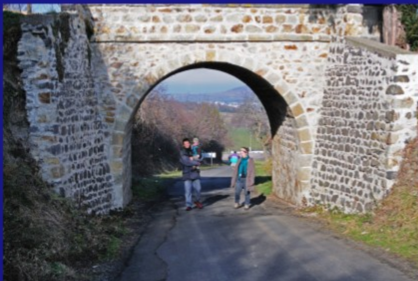
18 février : le pont Guilhaon
