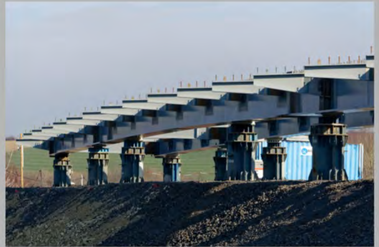
23 février : le nouveau pont de Gergovie sur l'A75 est construit au bord de la route
